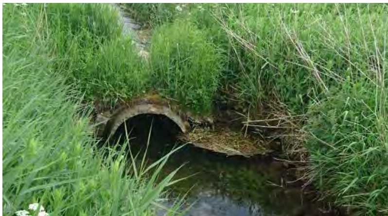
Figur 3-8 Gammel røroverkørsel, som ikke længere er i brug, i Skiveren Nord st. 1548
